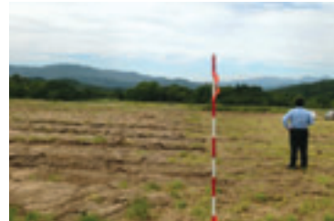
事前の現地視察や測量作業、地拵え作業を行いました。
