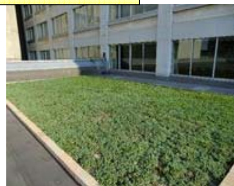
屋上に設置した緑化システム 北陸銀行本店ビル屋上
