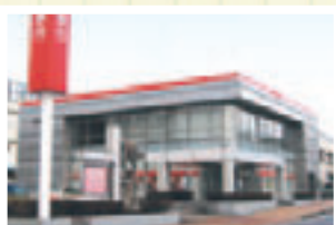
井波支店（明治34年3月15日開設）
