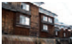
越中の小京都城端の町並み
