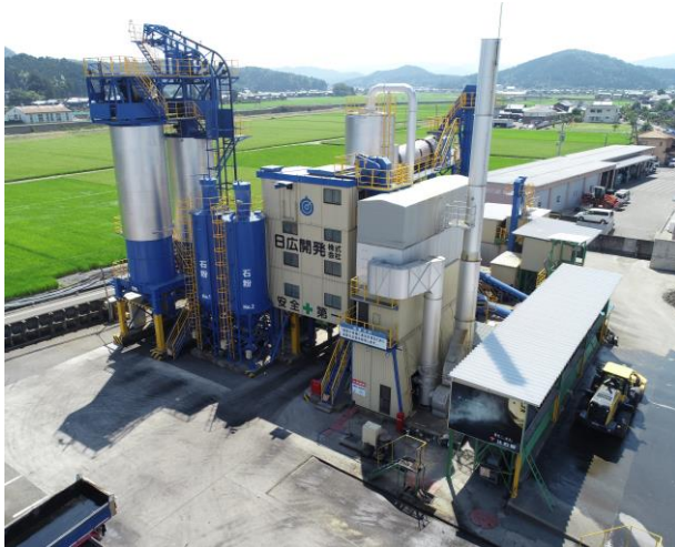
アスファルト合材製造プラント
