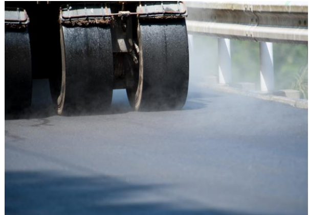
再生合材を活用したアスファルト（工事風景）
